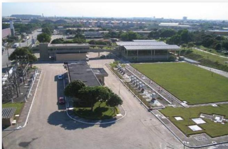
Figura 10 – Estação de Tratamento de Água V – ETA V
