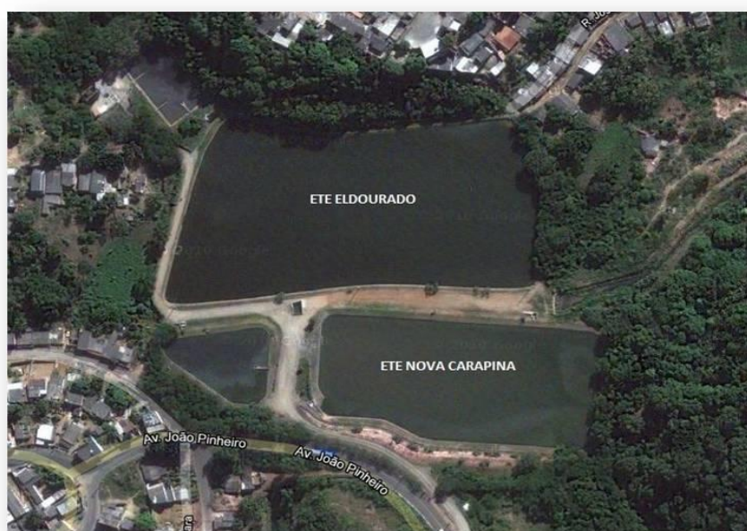
Figura 21 - Visão geral do ETE Eldorado
