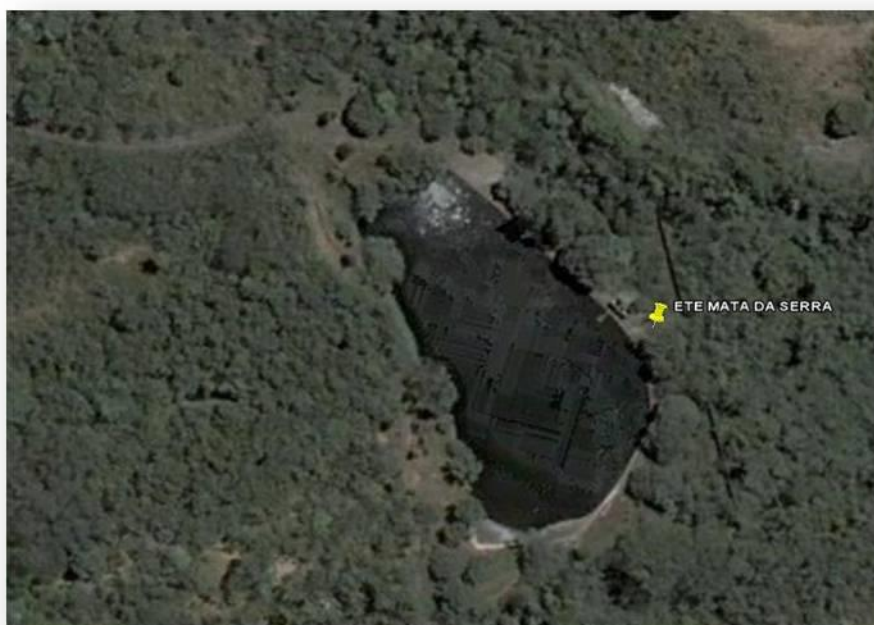
Figura 30 - Visão geral do ETE Mata da Serra
