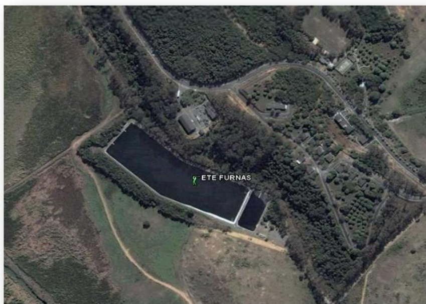
Figura 23 - Visão geral do ETE Furnas
