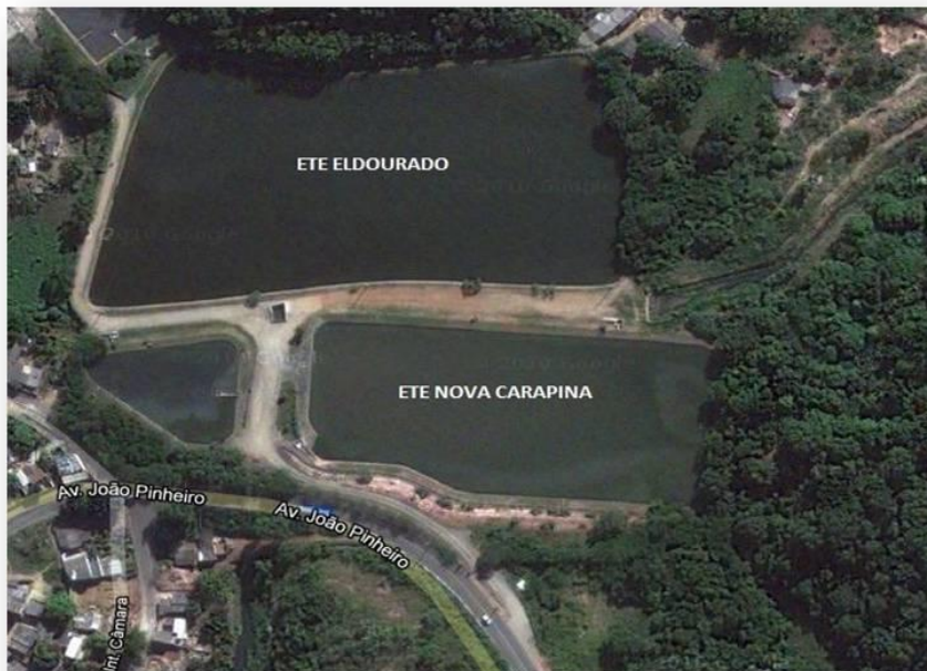
Figura 32 - Visão geral do ETE Nova Carapina
