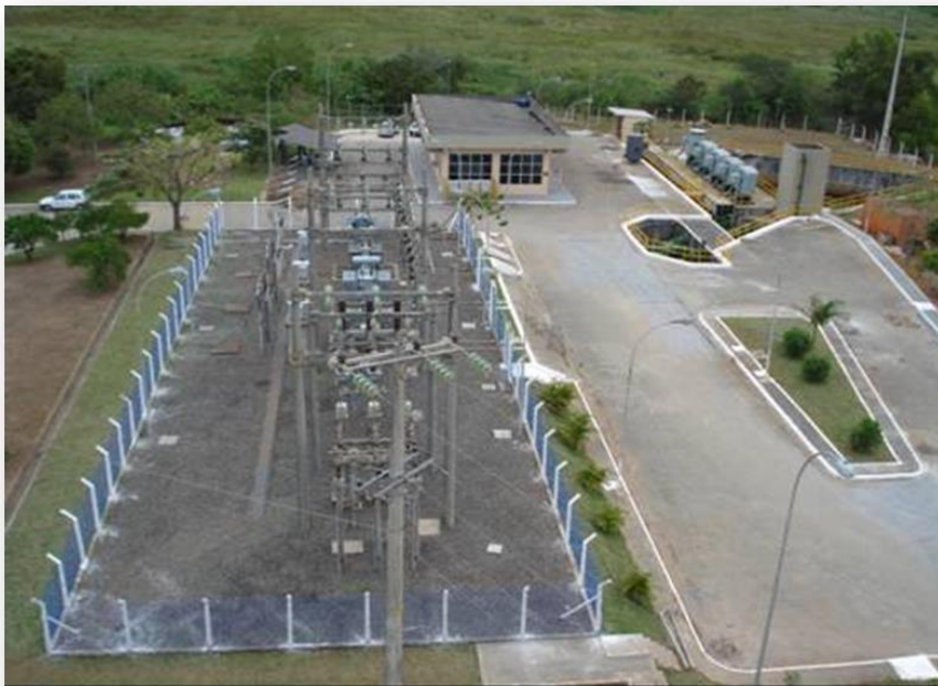
Figura 9 – Captação do subsistema Carapina
