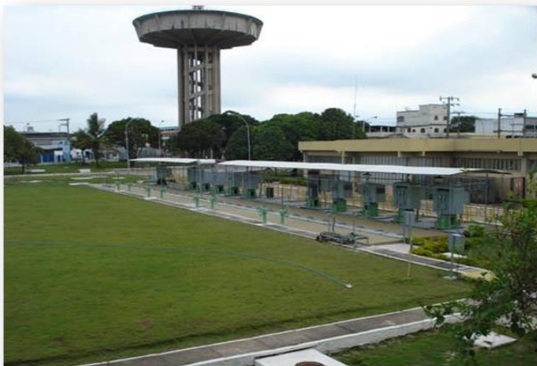
Figura 11 – Elevatória e Recalque de Água Tratada Planalto
