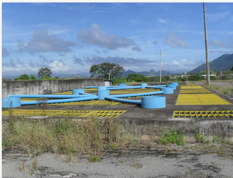
Figura 25 - Visão geral do ETE Jardim Carapina
