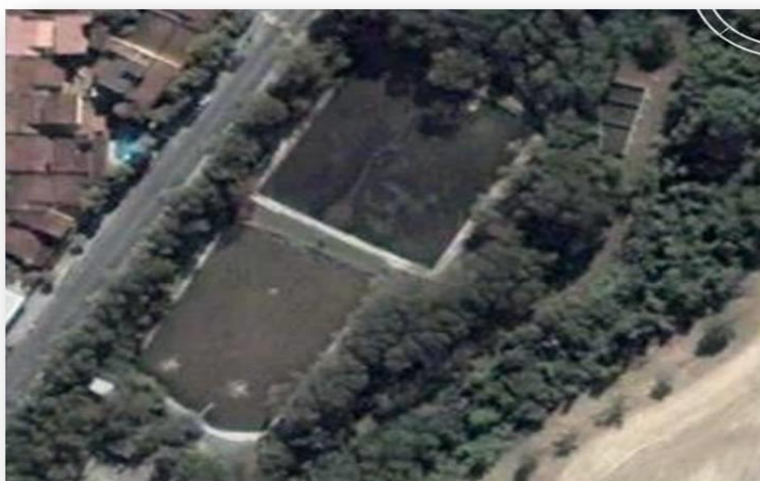
Figura 36 - Visão geral do ETE Valparaíso
